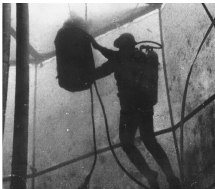
Ил. 129. А. Игнатъев за установкой гидрофона
