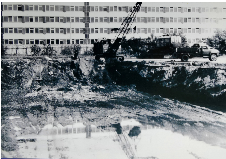
Начало строительства здания на ул. Фрунзе, 96, 1980 год
