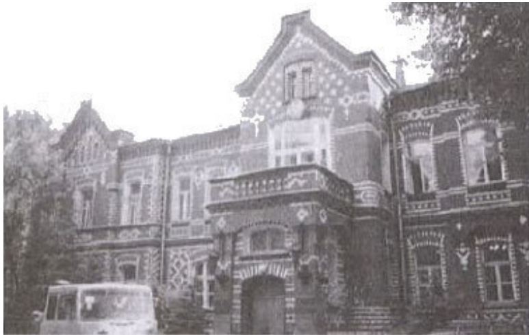
Административный корпус Алексеевской станции. 1890-е гг. Ныне завод «Мосводоприбор». (современный снимок автора)
