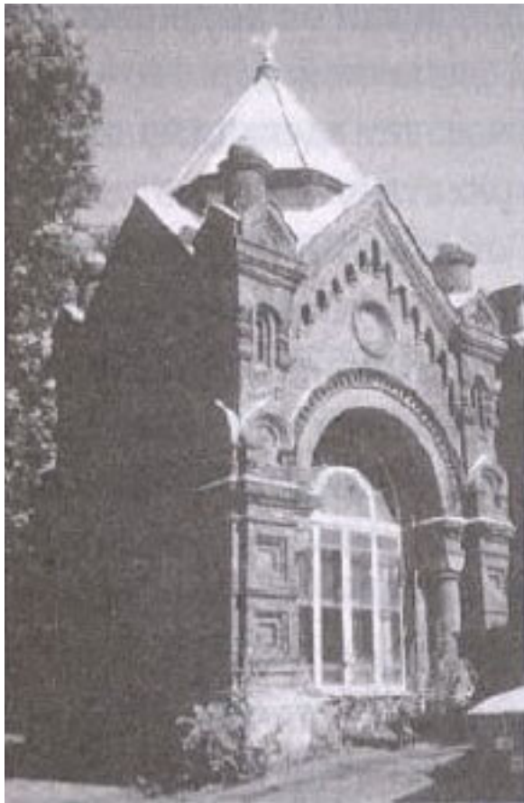
Эрлер машинного зала Мытищинской водокачки. 1890-е гг. (современный снимок автора)
