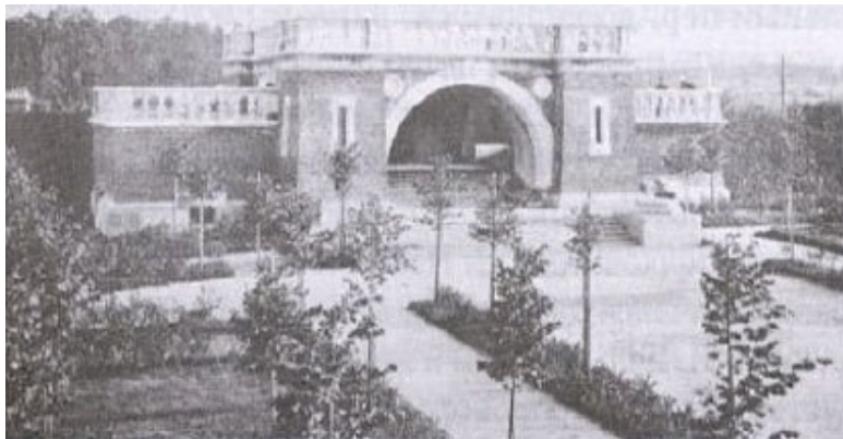
Алексеевская станция. Резервный накопитель воды. 1890-е гг.
