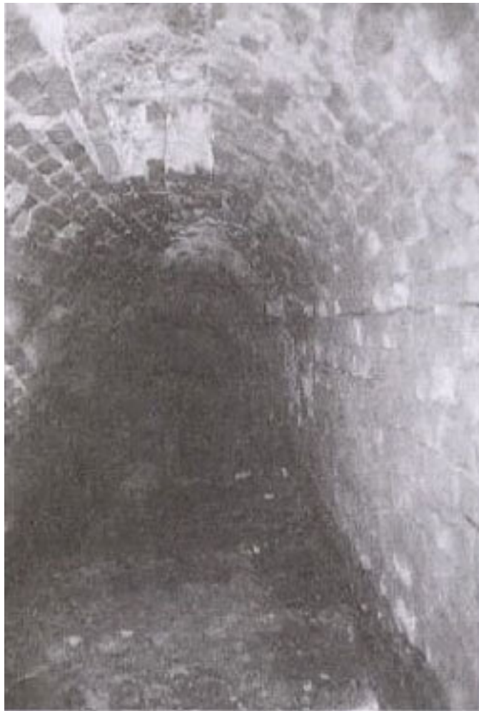
Галерея водопровода по проекту Баура (современный снимок)
