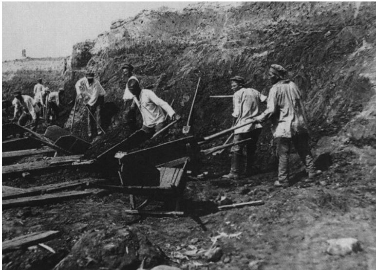
Работы на первой глубокой выемке.
