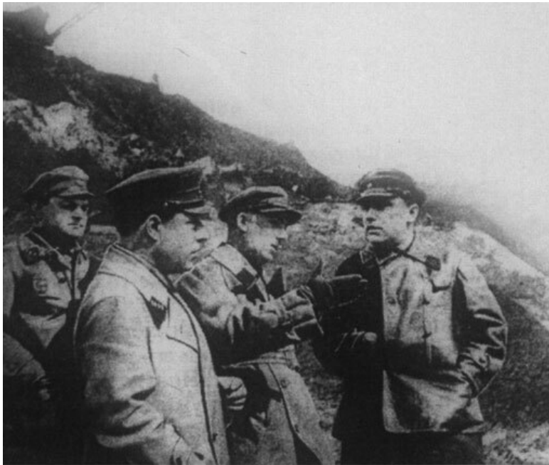
С. Г. Фирин, Л. И. Коган, Г. Г. Ягода, С. Я. Жук (слева-на-право) на стройке Волжского узла.
