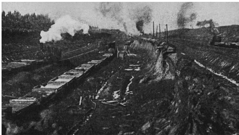
Земляные работы на Лесозаводском бугре.
