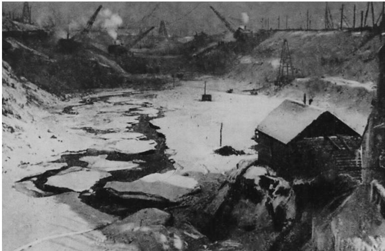
Земляные работы в котловане шлюза № 5.
