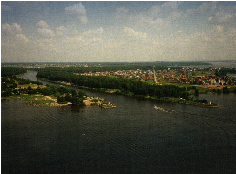
Выход канала в Клязьминское водохранилище у села Новосельцево (вид сверху).
