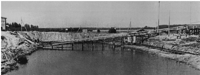
Строительство Учинской насосной станции. 1953 г.
