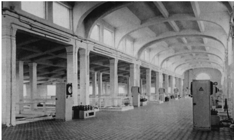
Зал фильтров Северной водопроводной станции.
