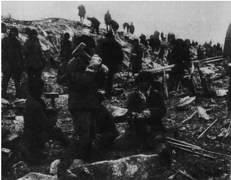
Выемка скальных пород после взрывных работ на трассе ББК.
