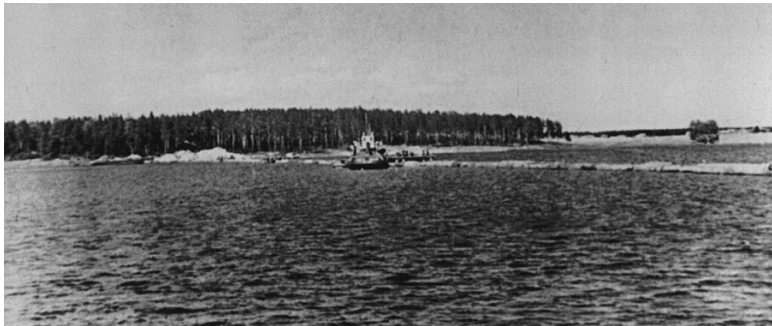
Прокладка дюкера через Клязьминское водохранилище.
