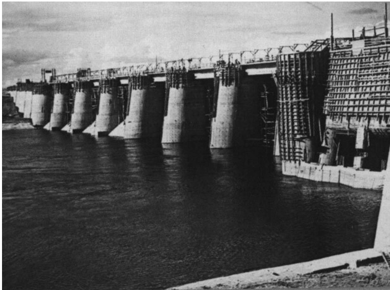
Бетонные опоры Ивановской плотины.
