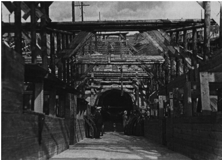
Строительство дюкера № 139 под рекой Клязьмой.
