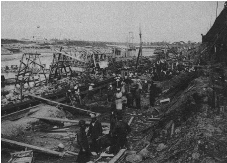
Работы на Центральном участке трассы канала.
